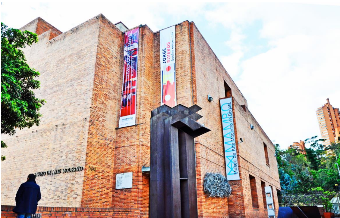
Figura 8. Fachada Museo de Arte Moderno de Bogotá. Fuente: Elaboración propia. 2015
