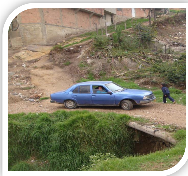
Figura 4-41: Vivienda en zona de deslizamiento y redes en terreno escarpado (Ciudadela-Sucre,
