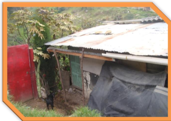
Figura 4-42: Vivienda con construcción en un nivel inicial de la tenencia segura
