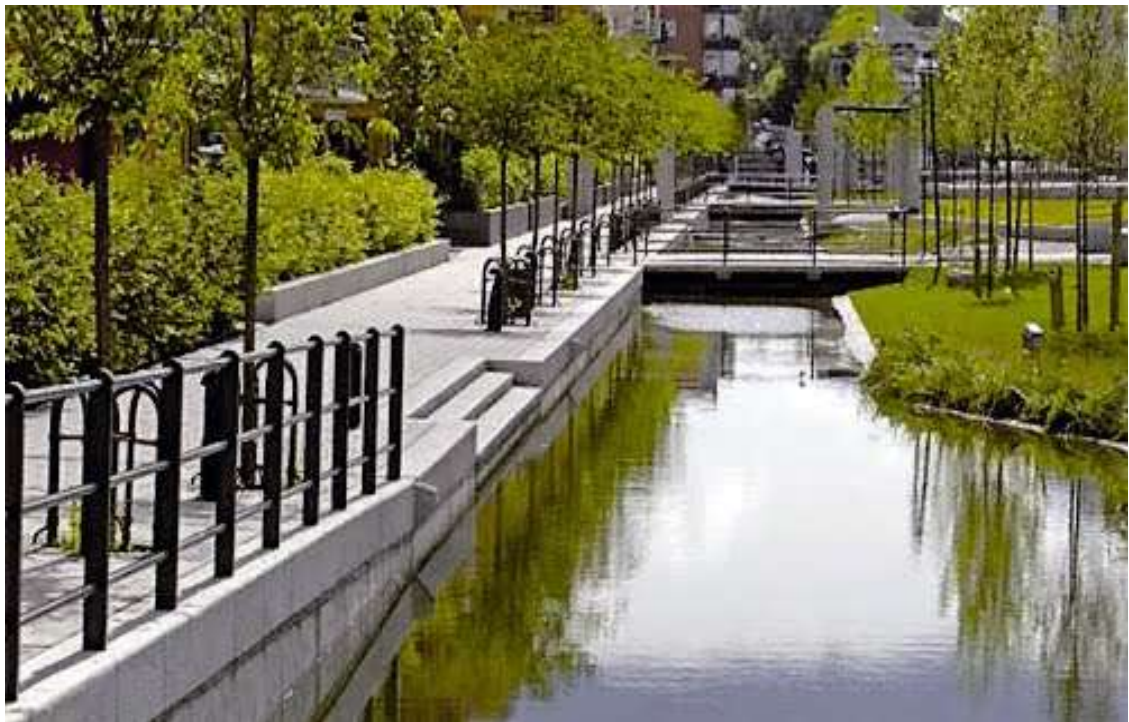
Figura 29. Estanque para recolección y regulación de aguas lluvias
