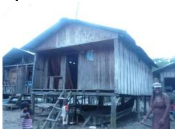
Imagen 20_ Estado actual de las viviendas
