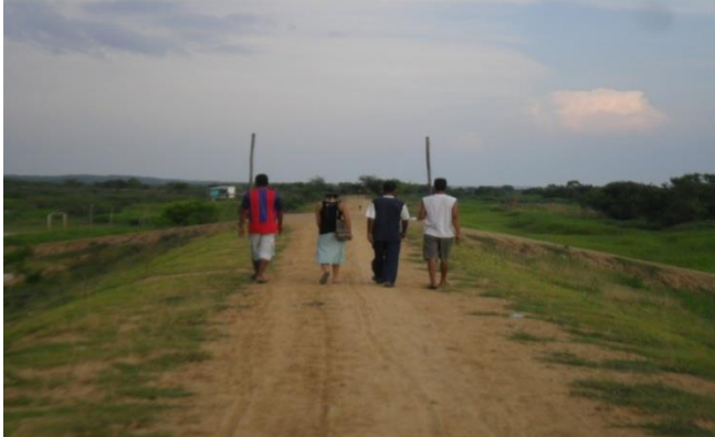
Figura 27. Terraplen de tierra con el que se busca evitar las inundaciones
