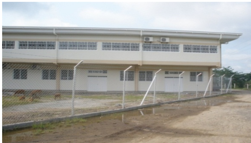
Figura 23. Vista Frontal Escuela de Palágua – Sede El Prado
